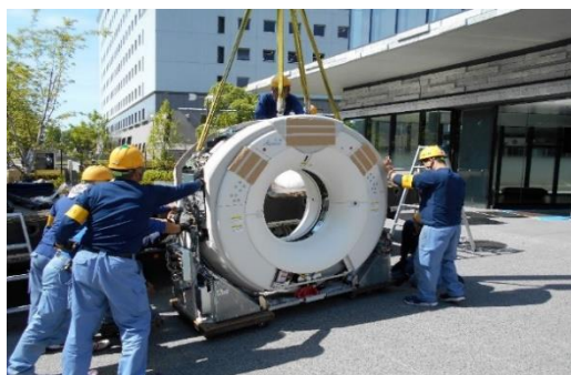
X線CT装置の搬入と据付
