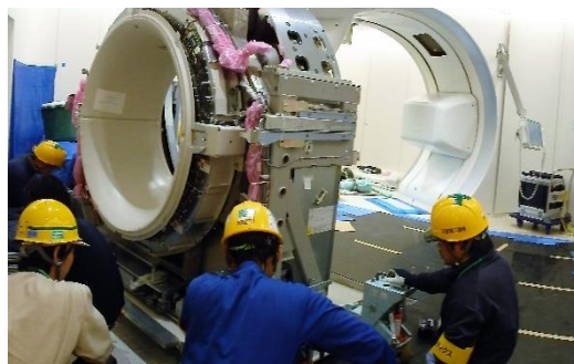
X線CT装置の搬入と据付
